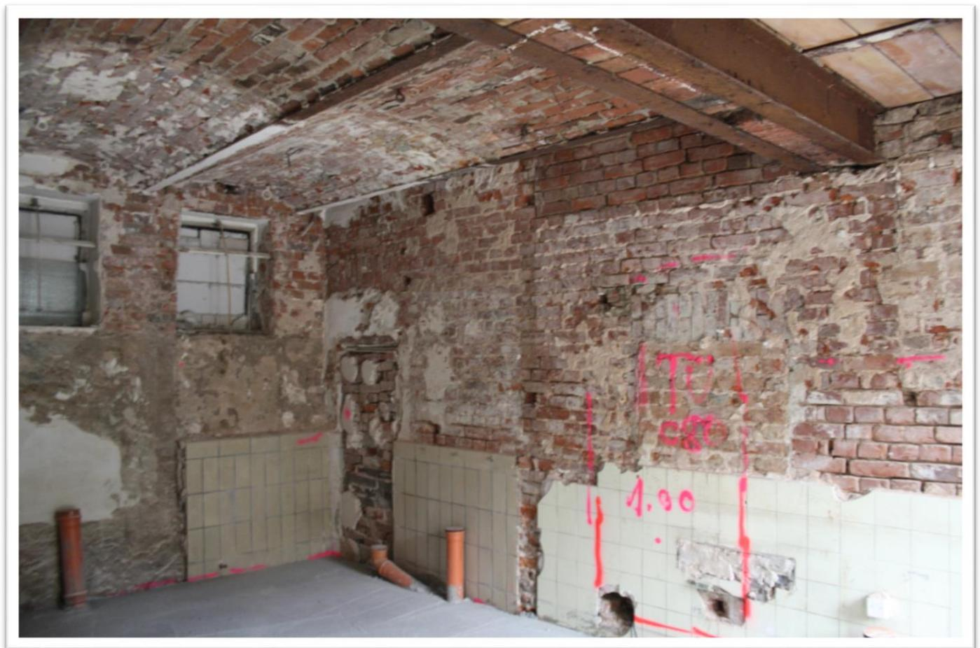
Die ehemalige Waschküche im Gebäudemittelteil nach dem kompletten Rückbau und der Entkernung. Hier entsteht der neue Sanitärbereich mit neuen Toilettenanlage.
