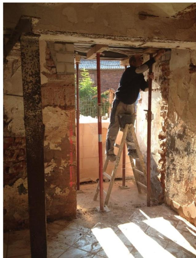
*Tragende Zwischenwände werden mit Stahl-Abfangungen ersetzt. Türbreiten werden vergrößert.*
