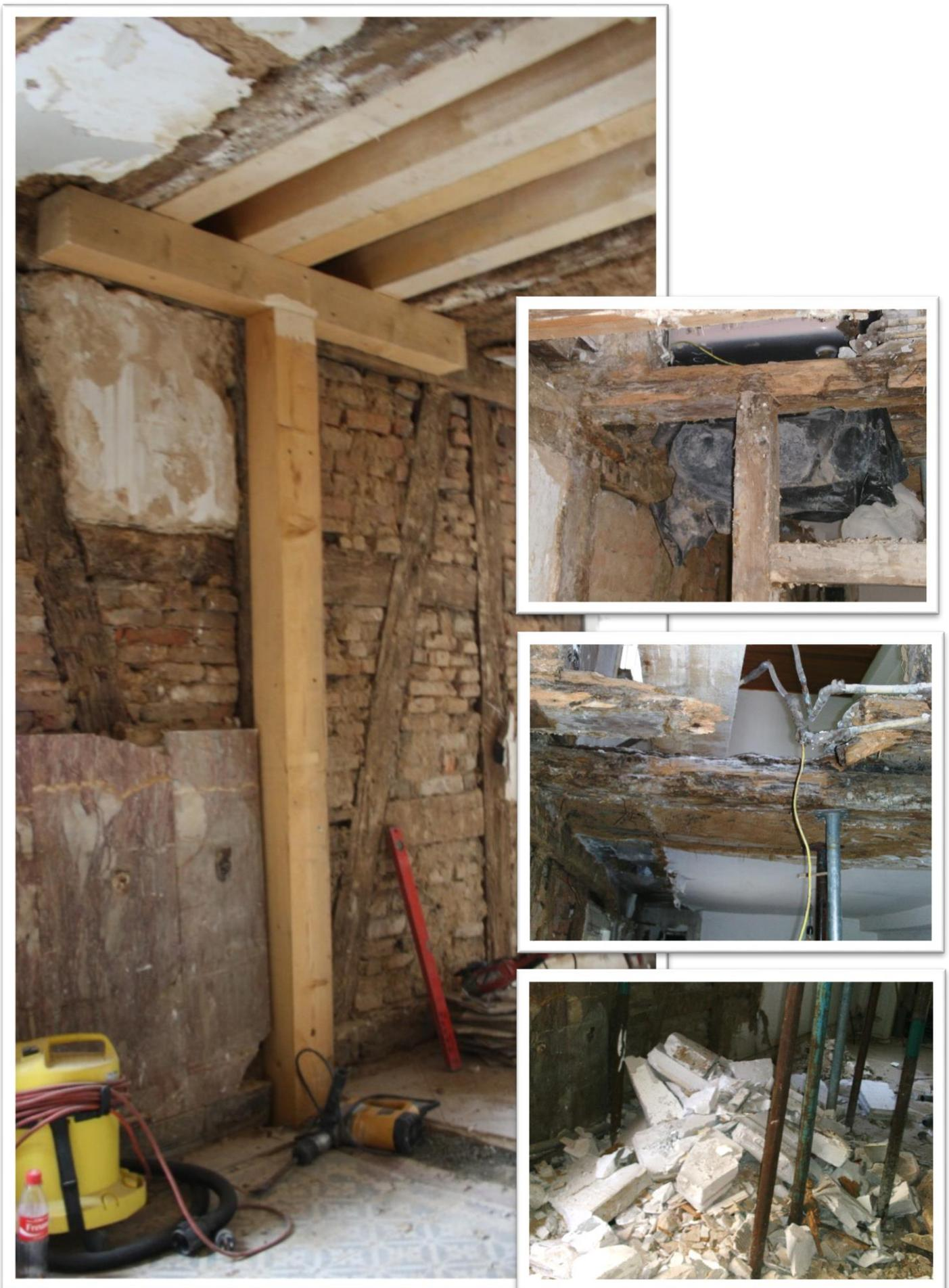
*Umfangreichste und technisch komplizierteste Umbauarbeit. Die Sanierung des ehemaligen Wasserschadens mit dem Ersetzen von tragenden Holzteilen in Wand- und Deckenbereichen in der Küche im Erdgeschoss.*
